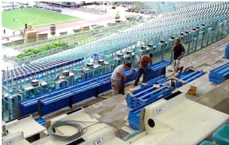
ALCUNE FASI DELLO SCARICO PRESSO LO STADIO OLIMPICO E DELLE OPERAZIONI DI MONTAGGIO E CABLAGGIO DELLE POSTAZIONI (FOTO A SINISTRA). LA TRIBUNA STAMPA COMPLETATA E OPERATIVA (FOTO A DESTRA).
